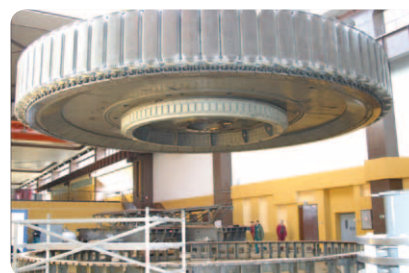
Obr. 5.: Rotor generátora s výkonom 90 MW, hmotnosťou cca 320 ton a priemerom cca 13 000 mm. Nastavením pólov s rozptylom 0,2 mm sa dosiahol pokles úrovne kmitania až o cca 40 %.
